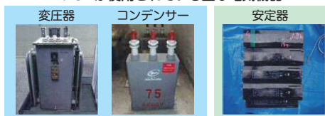
PCBが使用されている主な電気機器
