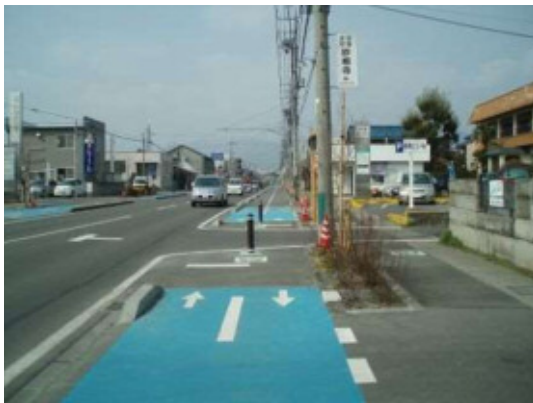
■ 自転車道の整備例（運動公園通り線）
