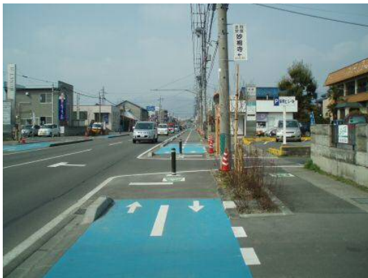
自転車道の整備例（運動公園通り線）
