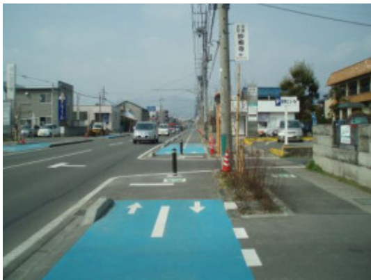
■ 自転車道の整備例（運動公園通り線）
