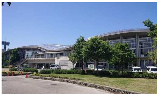
体育館・プール棟(右側が体育館)
