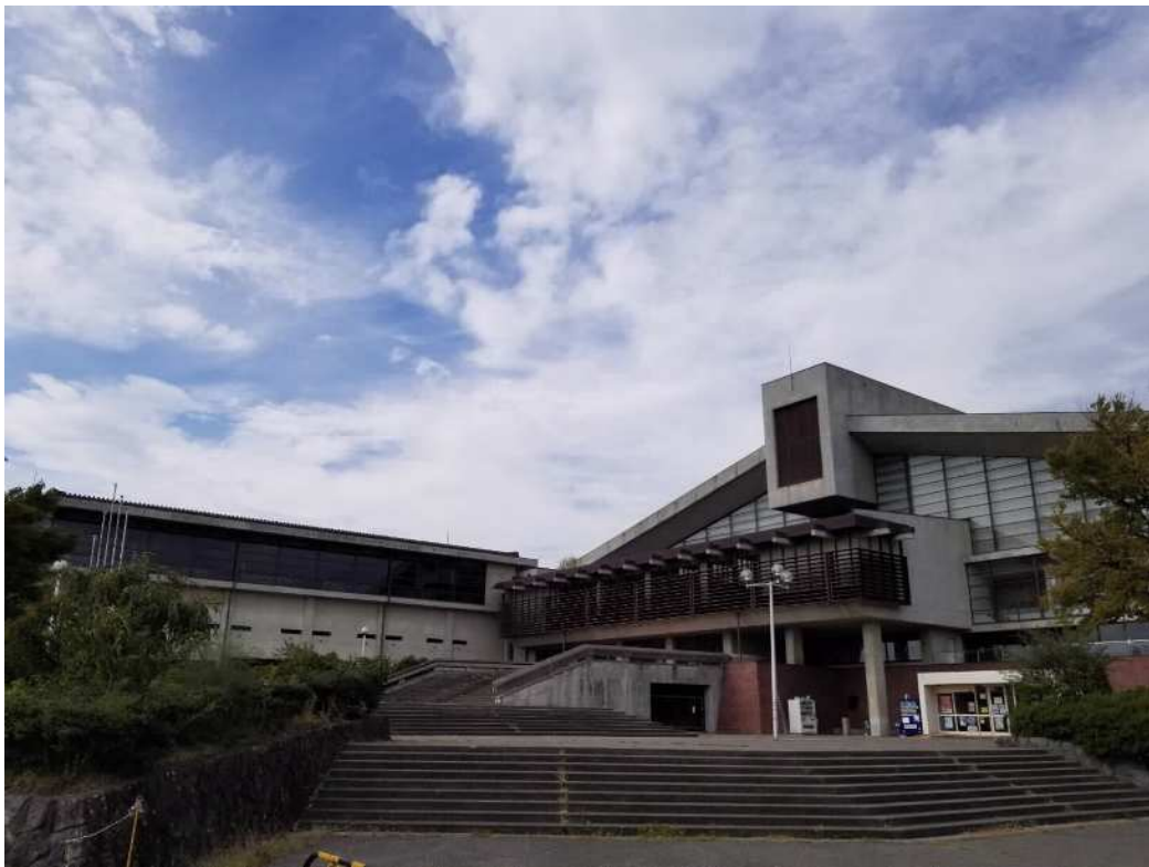
長野運動公園総合体育館（建設年月 昭和 53(1978)年 8 月）
