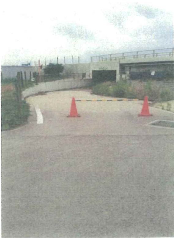
① 下流側から見た状況
