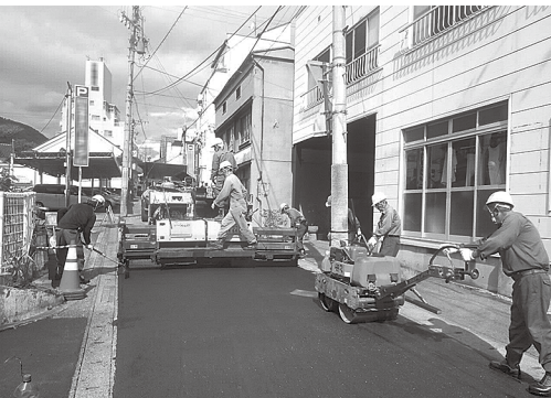
昨年度に実施した道路補修(舗装工事)の様子
