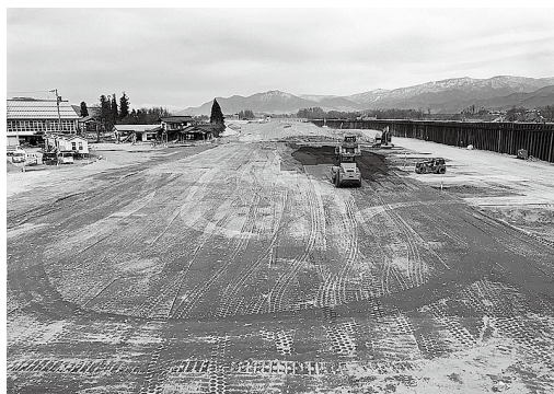
千曲川堤防決壊箇所の本復旧工事の様子（令和2年3月撮影）
