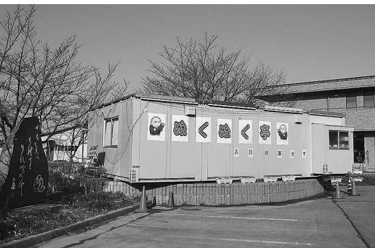
被災住民の交流拠点となっている「まちの縁側 ぬくぬく亭」(豊野地区)
