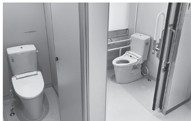
改修された中学校トイレの様子
