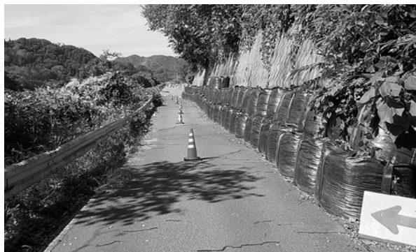
地滑りにより不安定化した市道法面が崩れないよう、応急対応として大型土のう90袋を配置した
