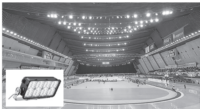
耐用年数が長く、消費電力が少ないLED照明に更新されるエムウェーブ。調光制御により演出効果も向上する
