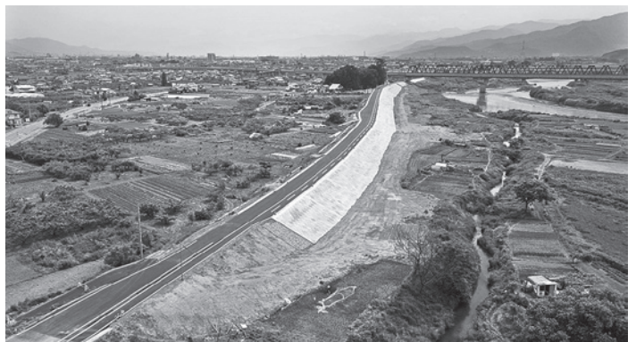
篠ノ井塩崎地区軻良根古神社付近の千曲川堤防復旧状況
