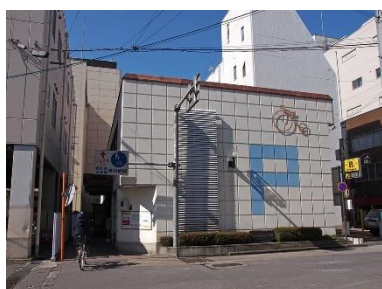
長野駅自転車駐車場
