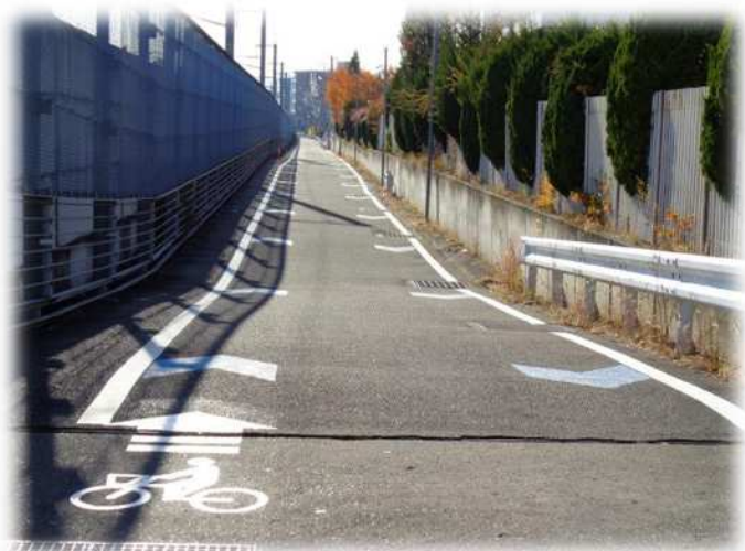
【矢羽根型路面標示設置】 (新幹線側道)
