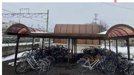
【北長野駅南口自転車駐車場屋根修繕】
