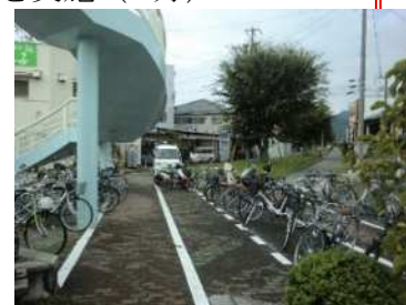
【丹波島橋南自転車駐車場】 （バス停周辺駐輪場区画線の整備）
