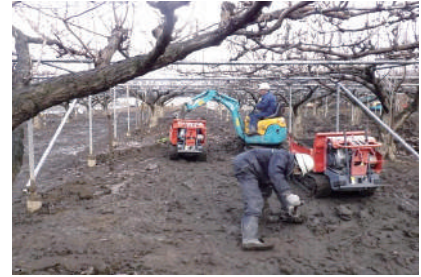
長沼地区における堤内土砂撤去作業
