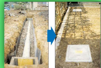
浸透トレンチ：（神奈川県相模原市）※1
