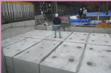
都市計画道路北部幹線（長野県長野市）
