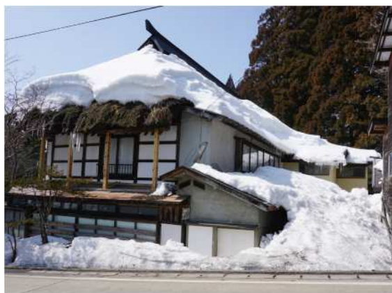
建物北側の雪溜まりの状況
