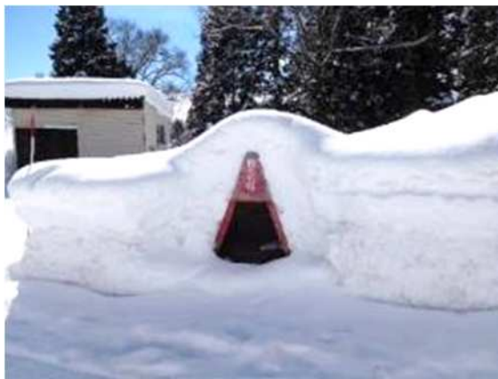
中社地区での防火水槽の積雪対策
