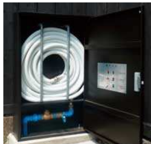
(参考) 易操作性消火栓の設置例
