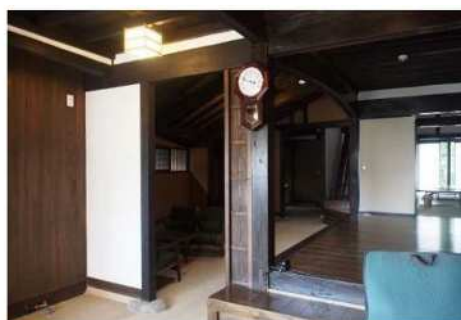
荒壁パネルによる補強壁の例 (鹿島市浜庄津町浜金屋町地区)
