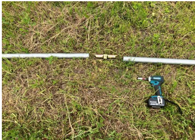
単管同士を直線ジョイントで接続
