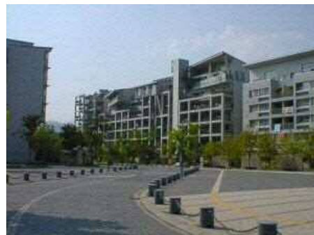
— 市営住宅 今井団地 —
