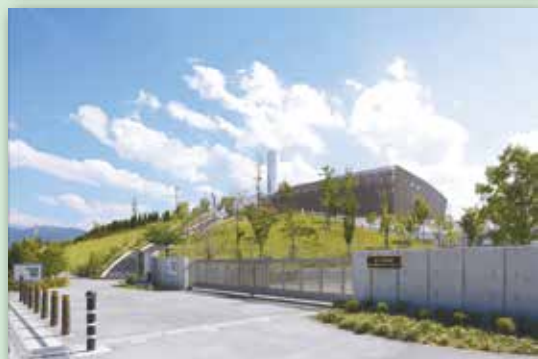
ながの環境 エネルギーセンター (松岡二丁目)
