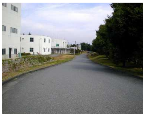
⑥: 焼却炉棟周辺
