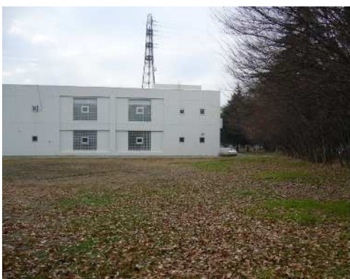
⑤: 機械濃縮棟周辺
