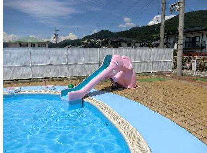
改修を行った「安茂里市民プール」
