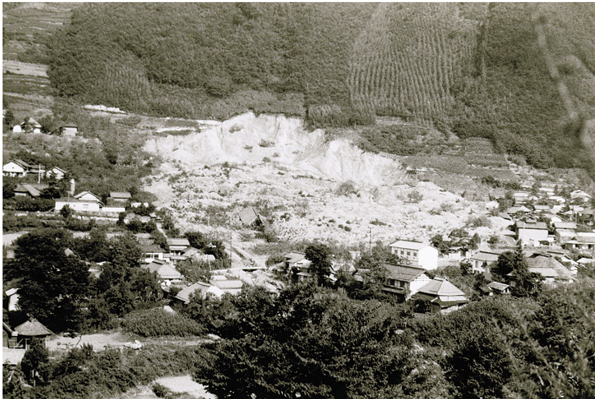
松代群発地震で発生した松代町牧内地区の地滑り(昭和41年9月17日)
