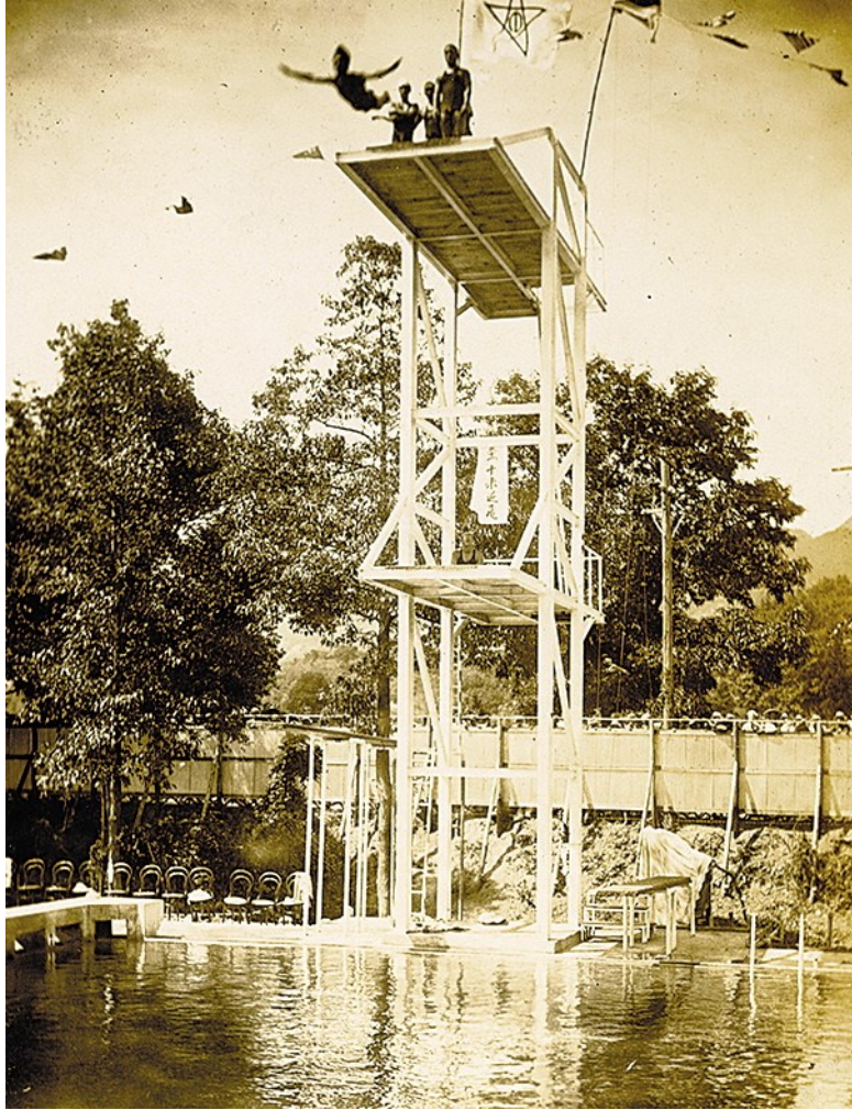
山王小学校西側に建設された市営水泳場の飛び込み台
