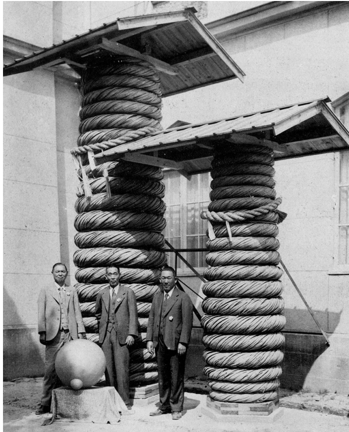
2尺玉花火の打ち上げに使われた大筒と名煙火師たち (昭和12年、長野商工祭)
