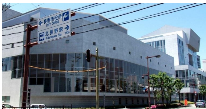
①長野市芸術館(手前)と長野市役所新第一庁舎(奥)
