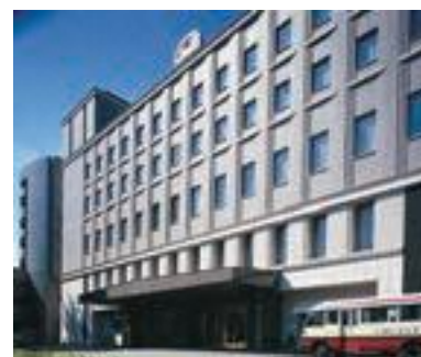
41 長野ホテル犀北館 新本館
