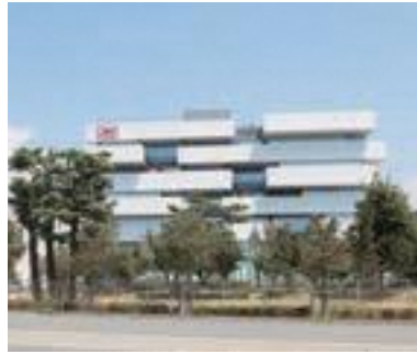
127 日本無線 先端技術センター
