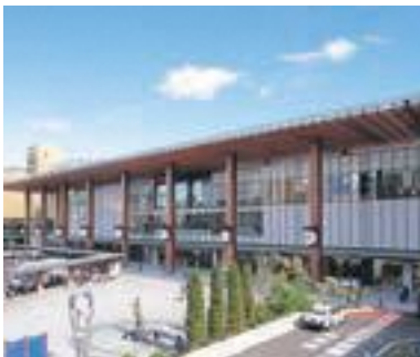
124 JR 長野駅 新駅ビルと善光寺口駅前広場
