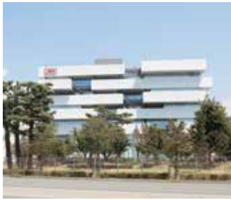
127 日本無線 先端技術センター
