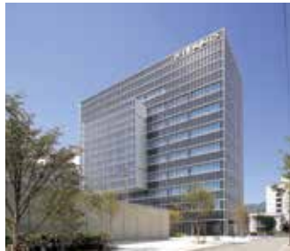
145 北野建設株式会社 長野本社ビル
