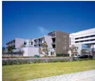
97 長野市民病院 中央棟、南病棟 (公共)
