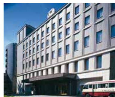
41 長野ホテル犀北館 新本館
