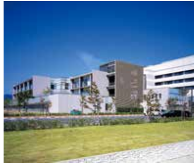
97 長野市民病院 中央棟、南病棟 (公共)
