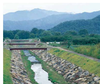
45 神明広田都市下水道堤外水路 (公共)
