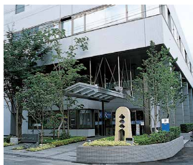
24 長野県労働金庫
