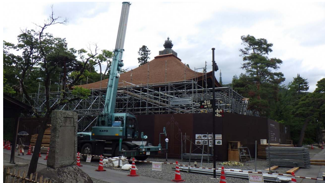
善光寺経蔵 仮設解体状況
