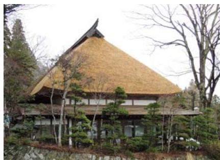
越志旅館 H26年度施工箇所 (客殿 西面屋根)
