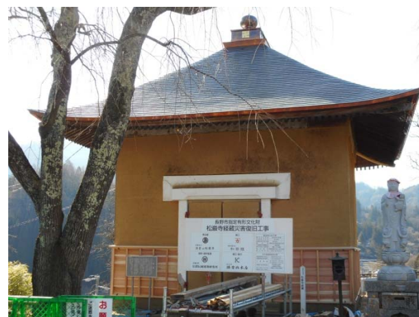
松巖寺経蔵 現況写真
