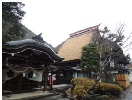
宿坊極意 H26年度施工箇所 (庫裡 西面屋根)
