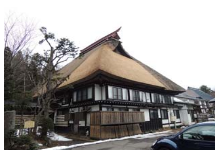
宿坊極意 H27年度施工箇所 (庫裡 南面屋根)
