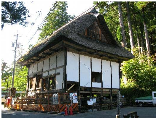
五斎神社拝殿 揚屋工事施工状況
