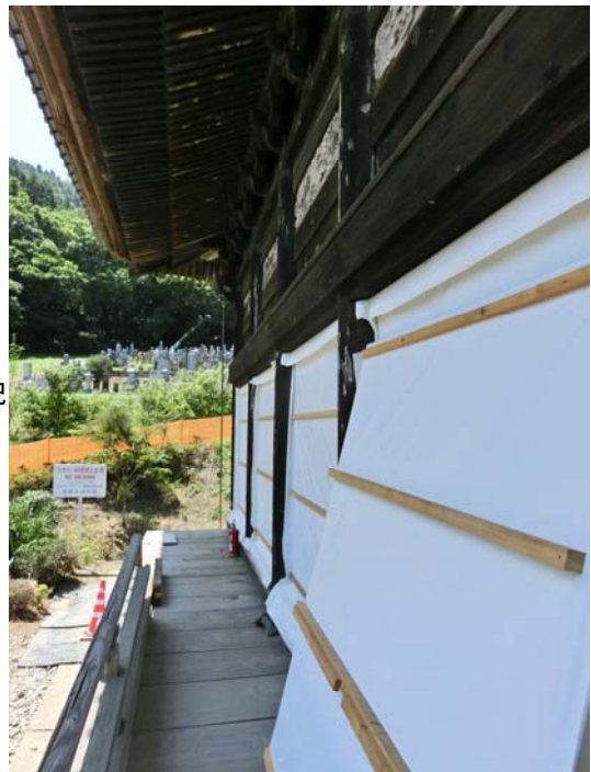
建具修理状況
