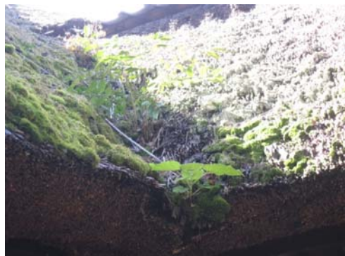
旧横田家住宅(主屋 北面屋根)
