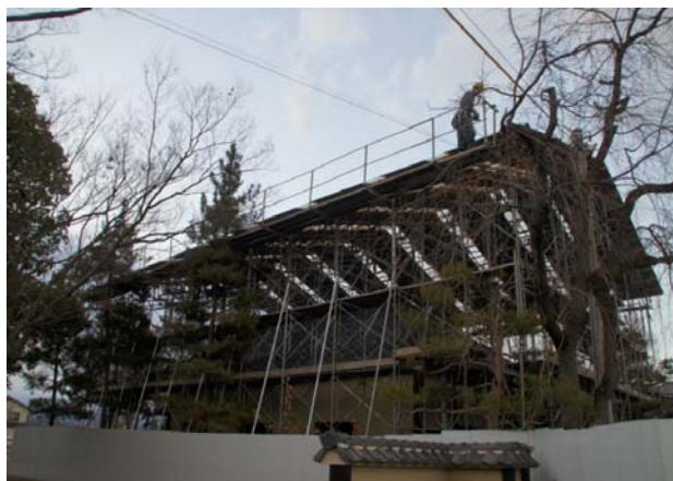
旧文武学校の保存修理状況
