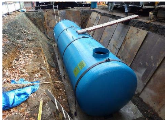
耐震性貯水槽設置状況
