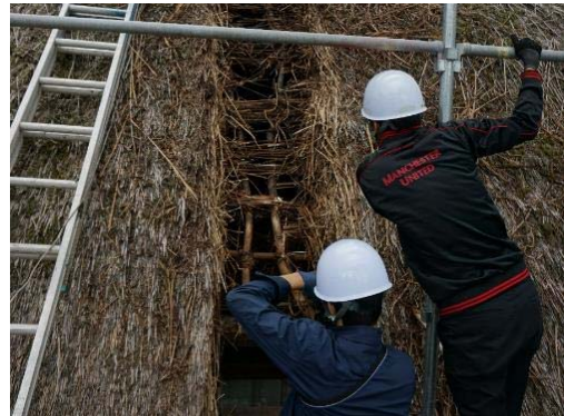
建造物の耐震性能調査(茅葺屋根の重量計測)
