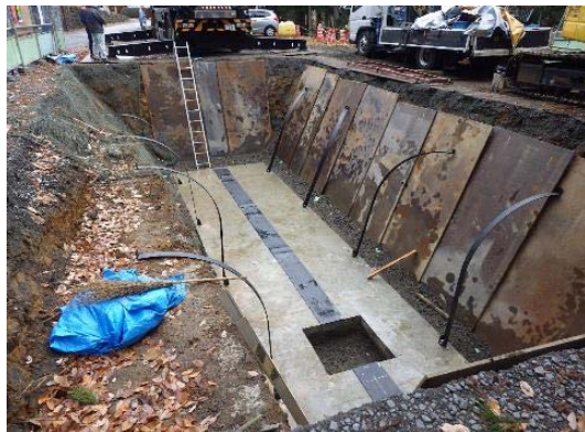
基礎コンクリート打設状況
