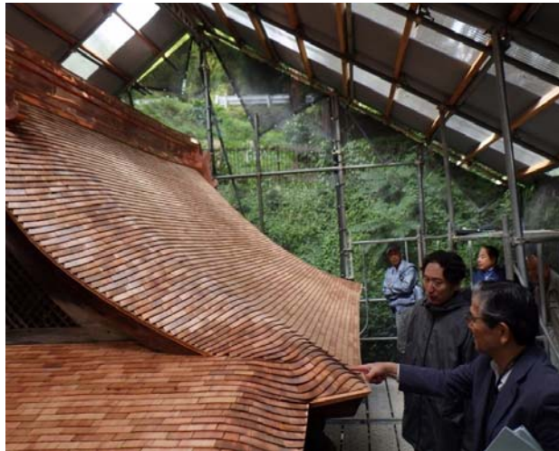
葛山落合神社の保存修理状況
