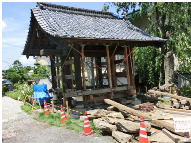
曳家基礎工事状況
