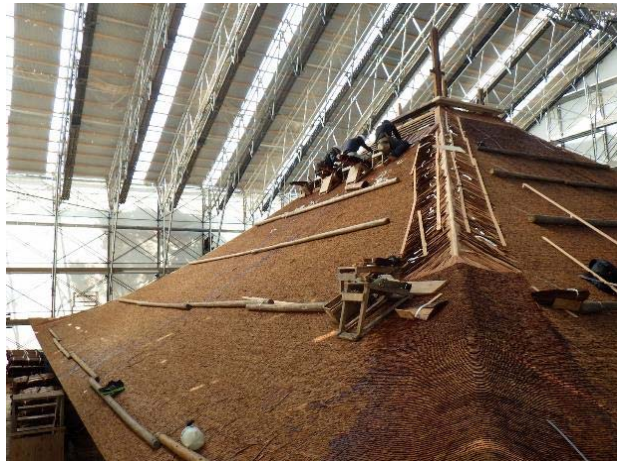
屋根修理工事状況
