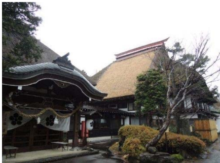
H26年度施工箇所 (庫裡 西面屋根)
