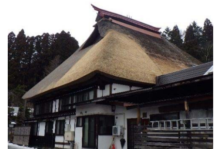
H28年度施工箇所 (庫裡 南東面屋根)
