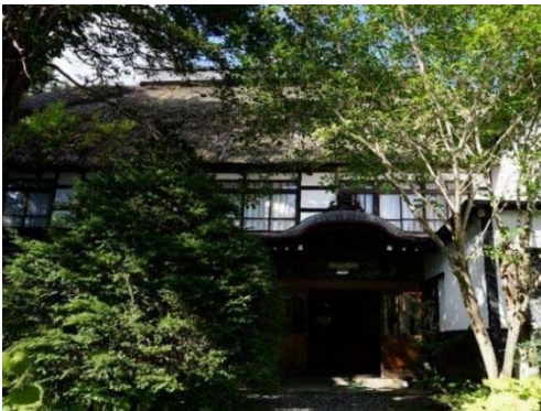
主屋正面（修理前）
