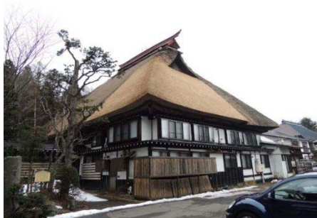
H27年度施工箇所 (庫裡 南西面屋根)
