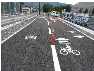
[No.1 松代町松代ロイヤルホテル南側整備済区間現況]
