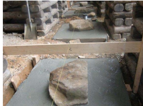
基礎修理工事（沈下対策）
