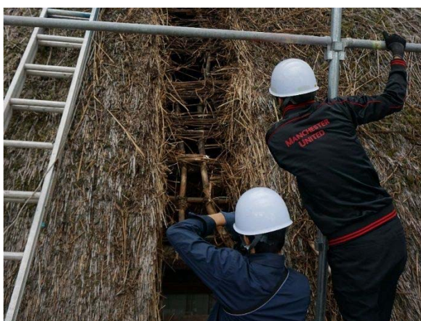
建造物の耐震性能調査（茅葺屋根の重量計測）
