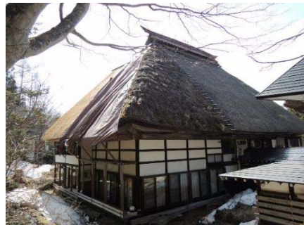
H30年度施工予定箇所 (庫裡 北西面屋根)
