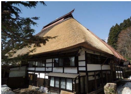
H29年度施工箇所 (庫裡 北東面屋根)
