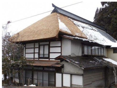
屋根東面(修理後)
