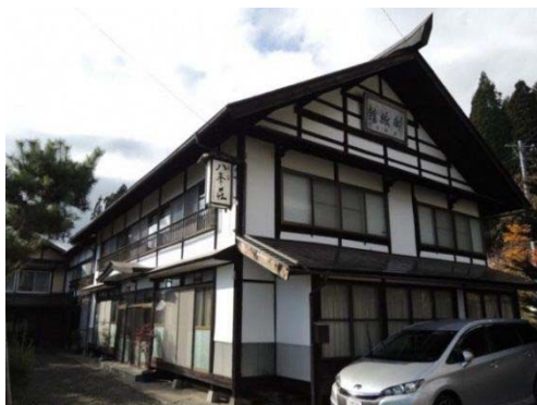
主屋全景(修理前)
