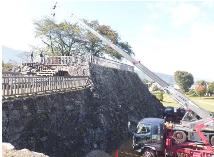
櫓台階段等撤去工事状況
