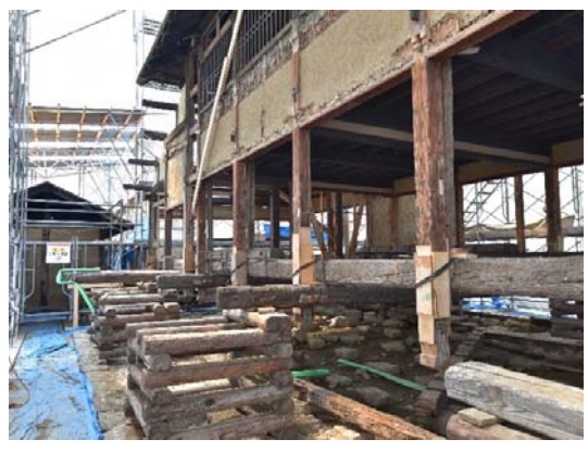
旧文武学校の保存修理状況
