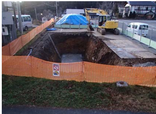
基礎コンクリート打設状況
