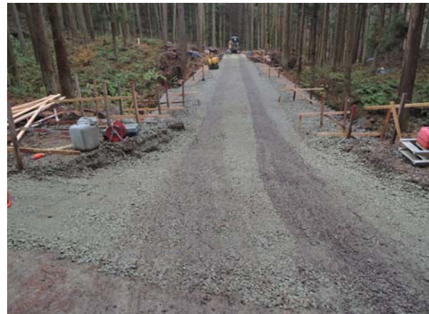
整備作業道設置工事(整備作業道路盤盛土)
