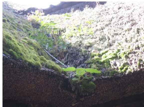
旧横田家住宅(主屋 北面屋根)
