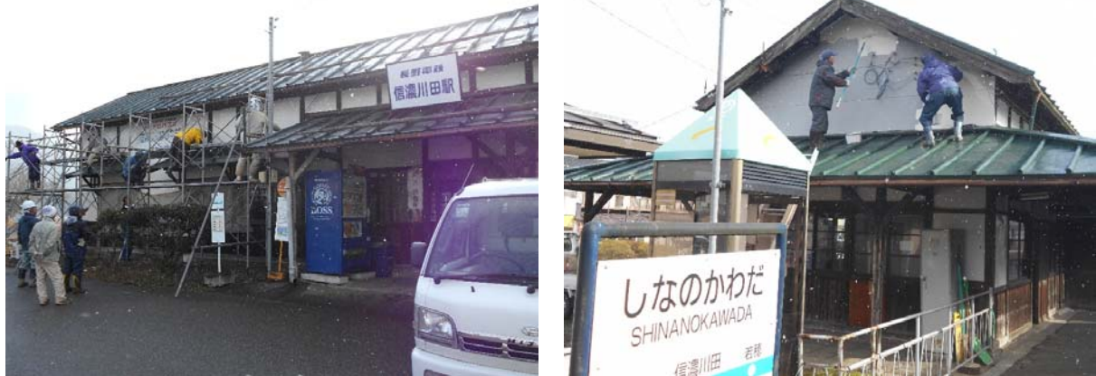
地元住民による駅舎壁面塗装(H30.12.15)
