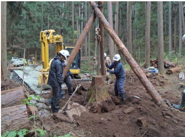
整備作業道設置工事(樹木の伐採・抜根)
