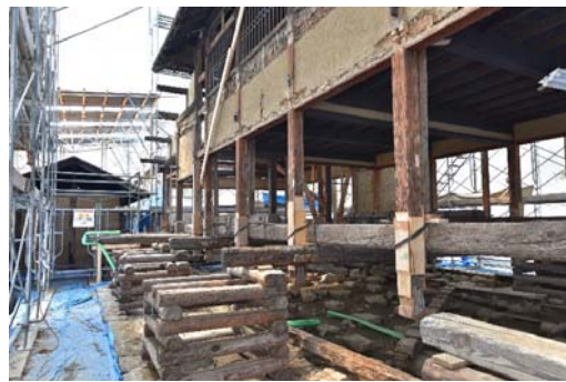
西序 揚屋工事状況
