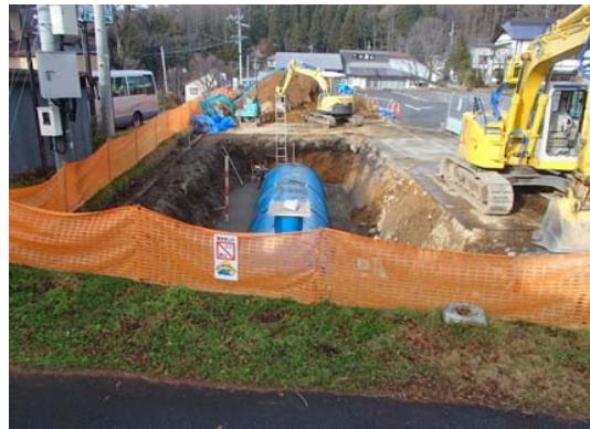
耐震性貯水槽設置状況
