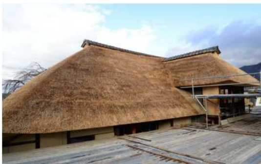
屋根工事 葺き替え状況（主屋）
