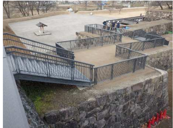
櫓台階段・柵の再整備
