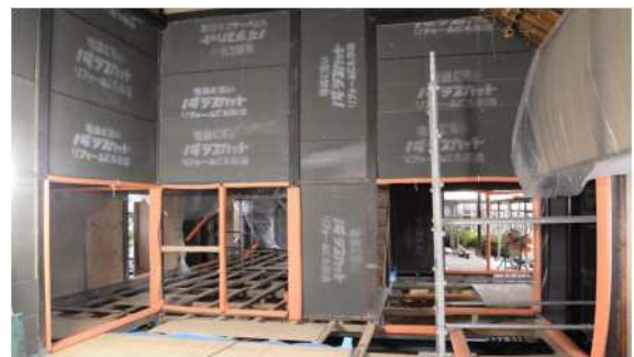
耐震補強工事（主屋）
