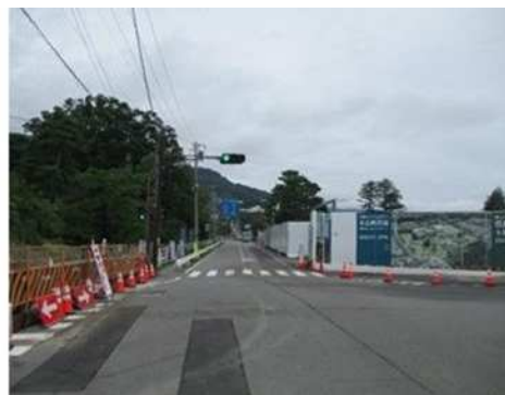
歩道橋撤去後
