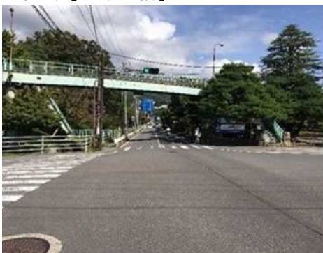
歩道橋撤去前
