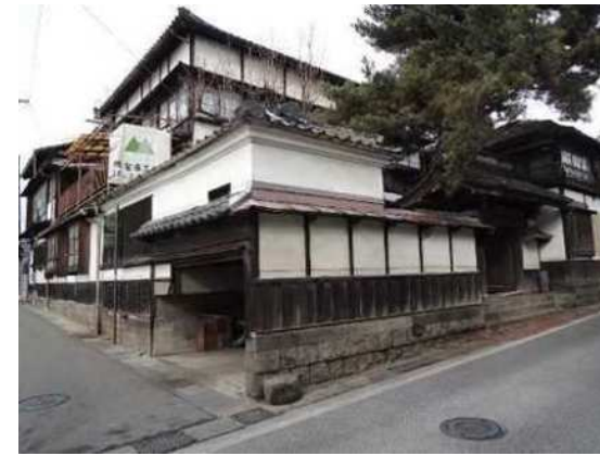
写真1-1 敷地外観（南東から）撮影：R3.1.22
