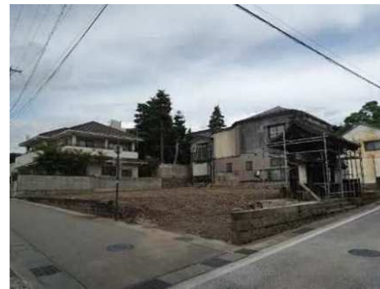
写真1-2 敷地外観（南東から）撮影：R3.6.30
