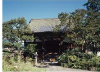
劣化の進む大英寺本堂 (長野県宝)
