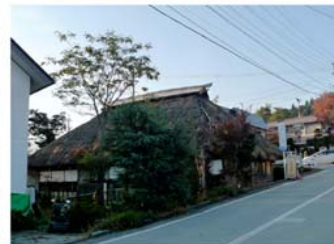
原山家住宅旧主屋(明治初期以前)
