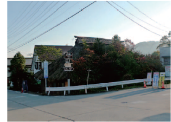
空き家となって急速に老朽化が進む民家
