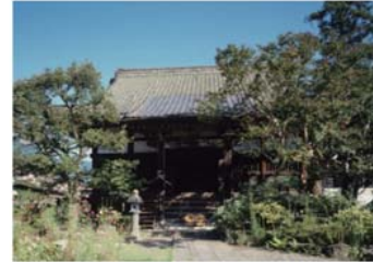
劣化の進む大英寺本堂 (長野県宝)
