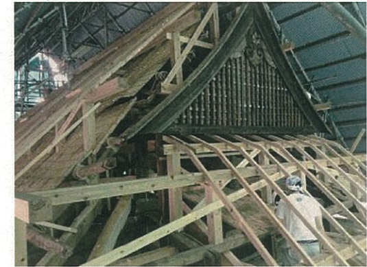
松巖寺観音堂 修理状況（屋根部）
