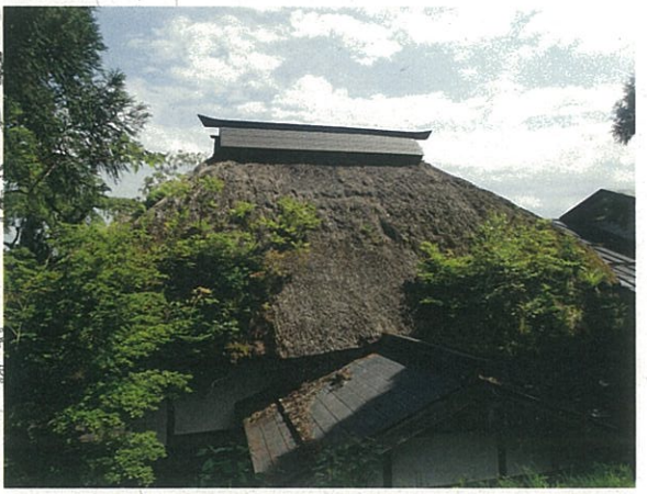
主屋(指定部分) 北面の現況
