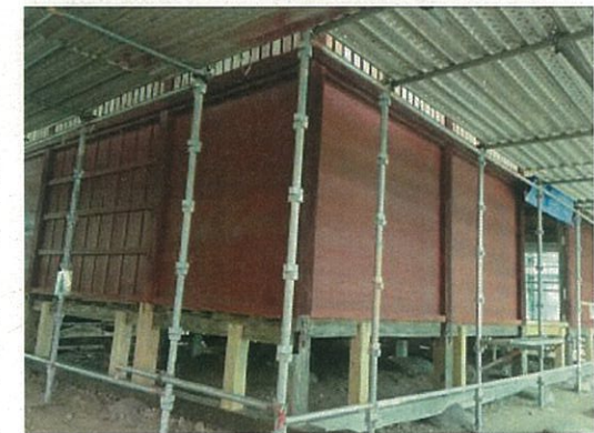
松巖寺観音堂 修理状況（基礎部）
