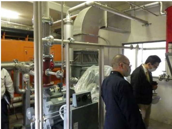
防災施設整備の実施状況(消火栓エンジンポンプ・制御盤等の更新)
