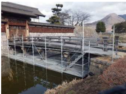
太鼓門前橋・二の丸引橋等の整備工事
