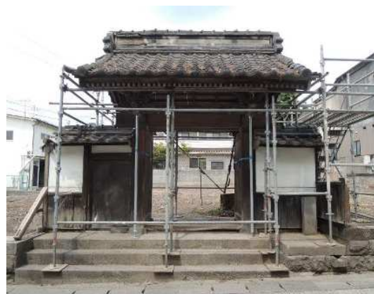
写真2 門外観(東から)撮影
