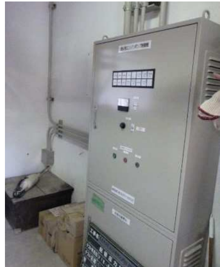
防災施設整備の実施状況(消火栓エンジンポンプ・制御盤等の更新)
