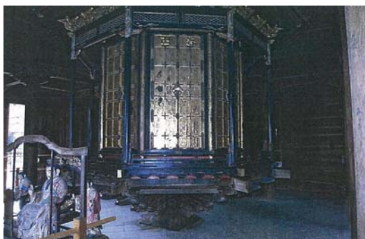
建物内部状況(北西より)
