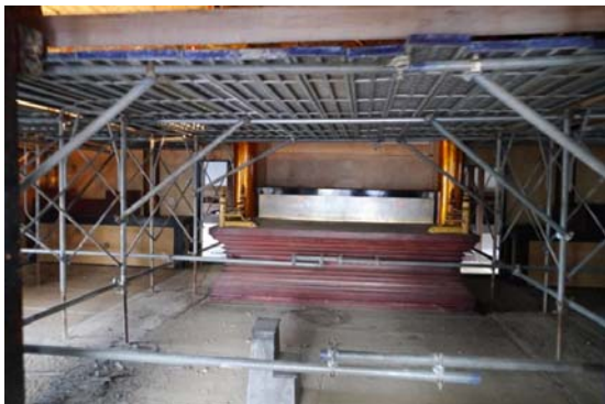
大英寺本堂内部 解体途中
