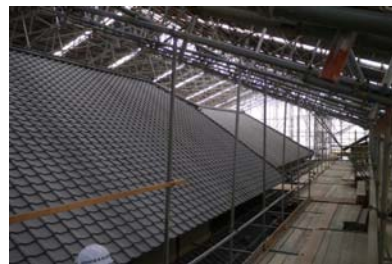
文学所 修理工事状況
