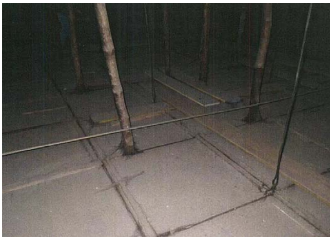
善光寺本堂 小屋裏吊天井
