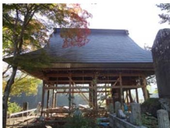
工事状況写真(平成25年11月状況)
