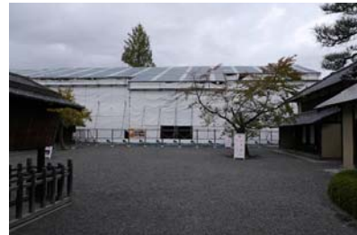
文学所 工事外観
