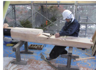
旧松代藩鐘楼の修理
