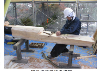
旧松代藩鐘楼の修理
