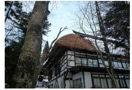
横倉旅館 H26年度施工箇所 (主屋 南西面屋根)
