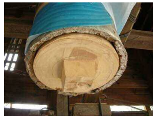
木部修理状況
