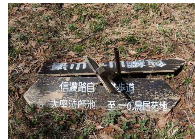
破損している歩行者案内板 (善光寺～一の鳥居)
