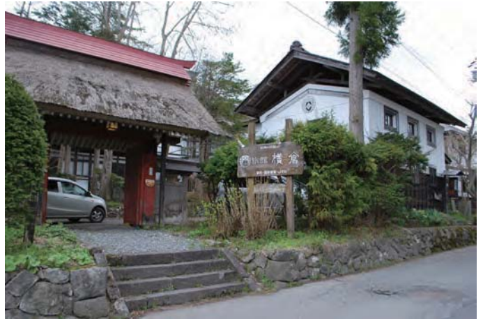
写真2 門外観（南西から）
