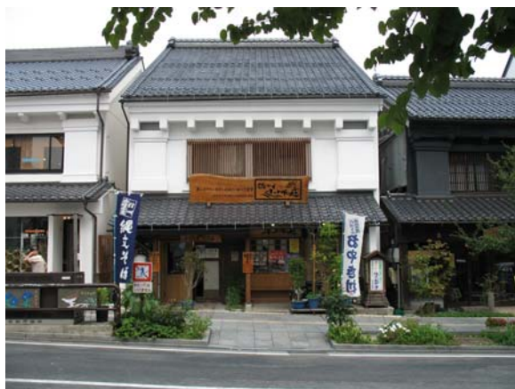
下屋上の伝統的な広告物を設置している店舗
