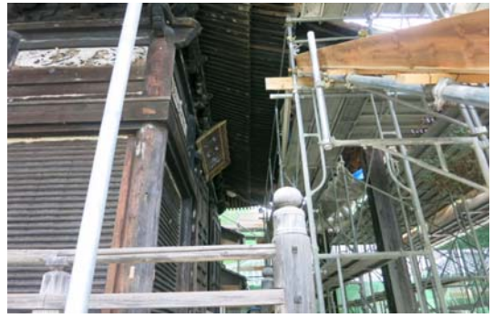
屋根修理状況
