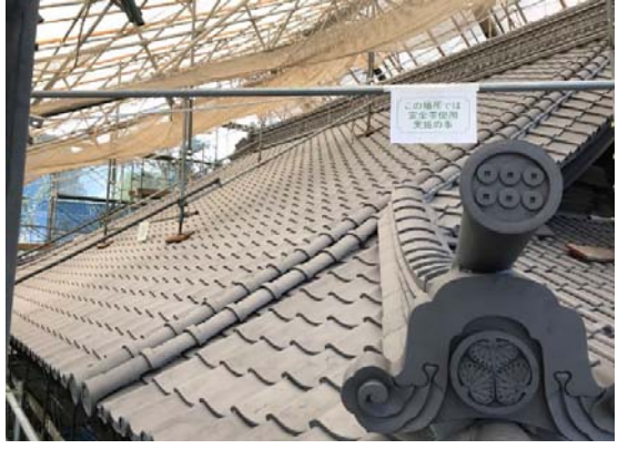
大英寺本堂屋根瓦吹き替え
