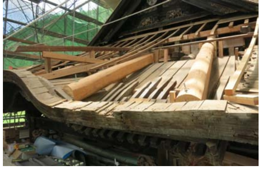
屋根修理状況
