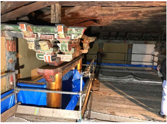
内陣解体状況
