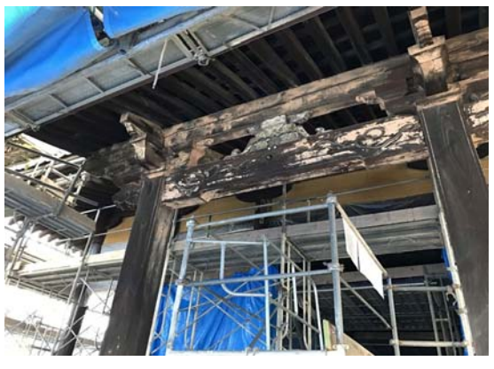
外壁他修理状況
