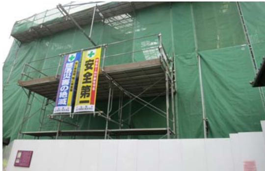
覆屋設置状況
