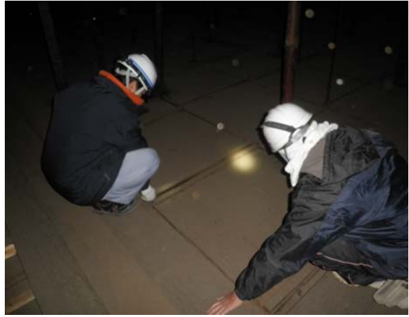
善光寺本堂 天井板落下防止調査(内陣)
