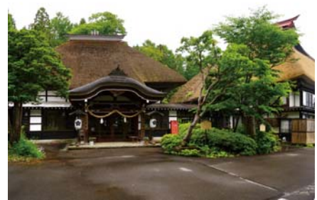
代表的な伝統的建造物(中社区)
