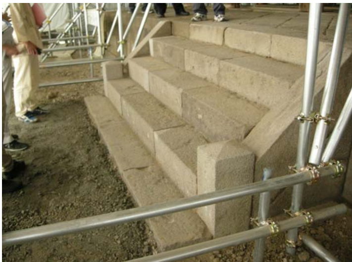
善光寺経蔵 基礎工事
