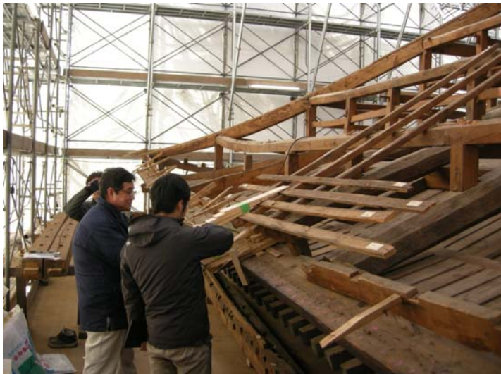
善光寺経蔵 屋根工事 (文化庁指導)
