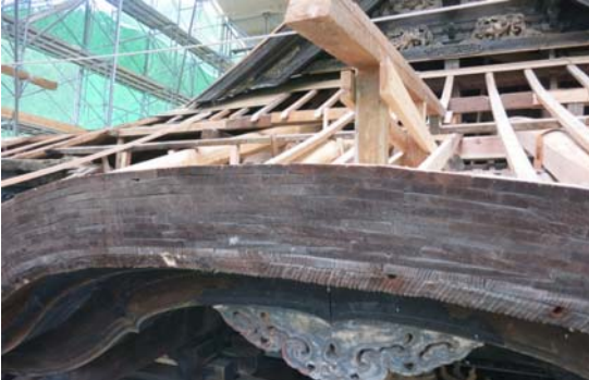
屋根修理状況
