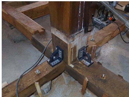
塚田家(白金家)主屋 耐震補強工事施工状況
