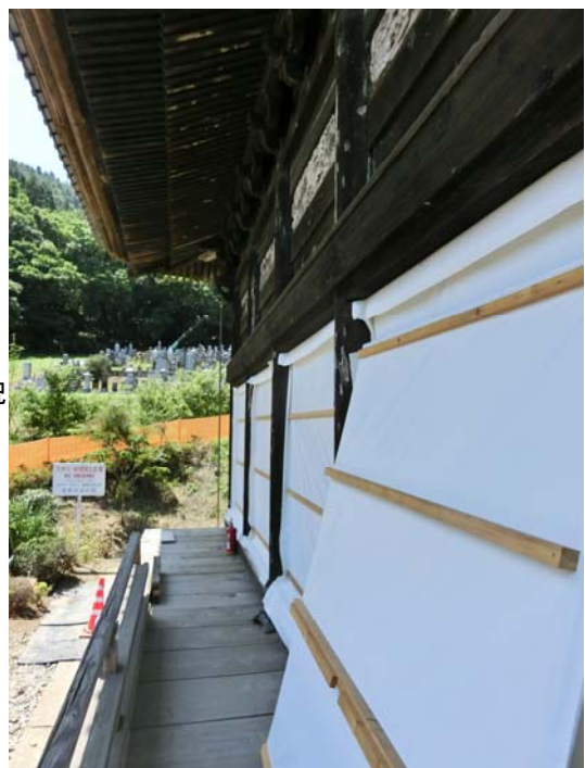
建具修理状況
