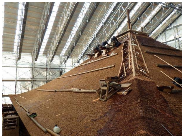
屋根修理工事状況
