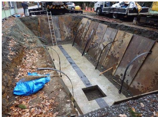
基礎コンクリート打設状況
