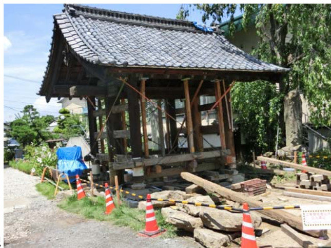
曳家基礎工事状況
