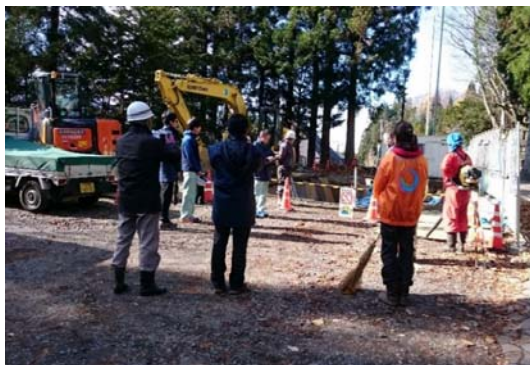
耐震性貯水槽設置工事の現場見学会 (H29.11.17 参加者9名)
