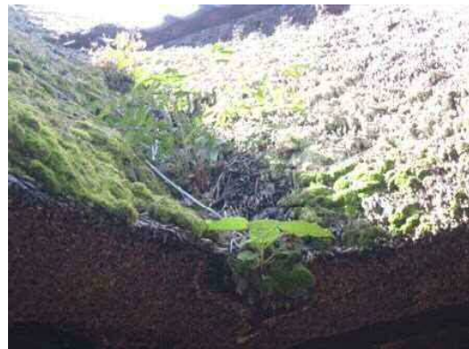
旧横田家住宅(主屋 北面屋根)
