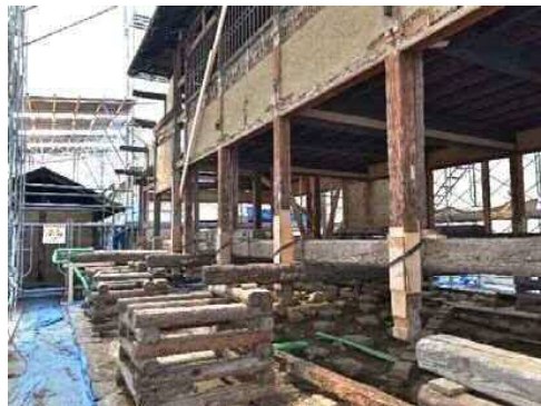
旧文武学校の保存修理状況
