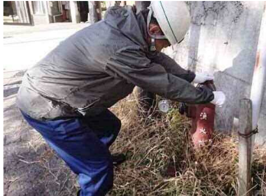
保存地区内の消火栓水圧調査
