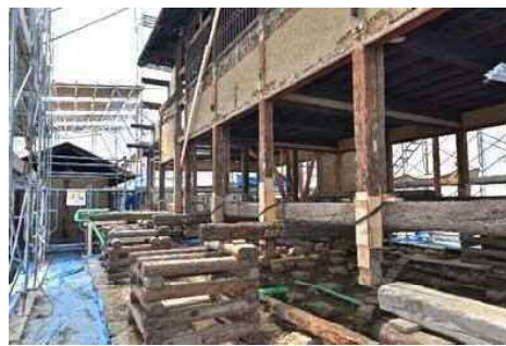
西序 揚屋工事状況
