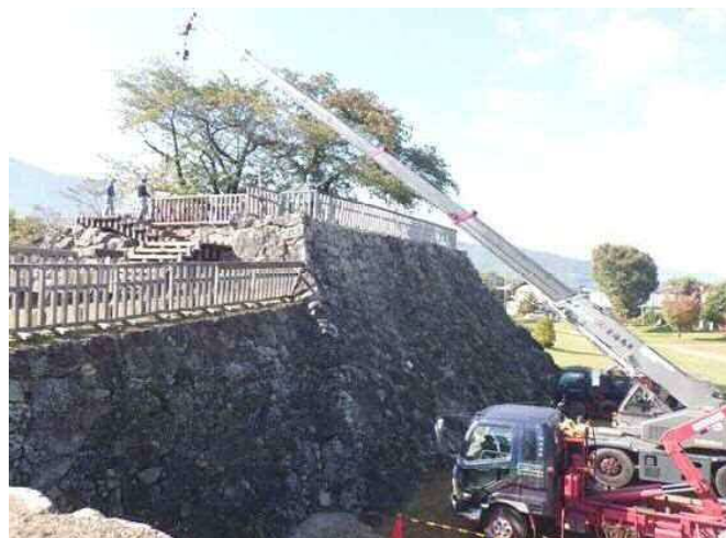
櫓台階段等撤去工事状況
