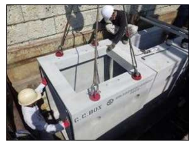
特殊部設置状況
