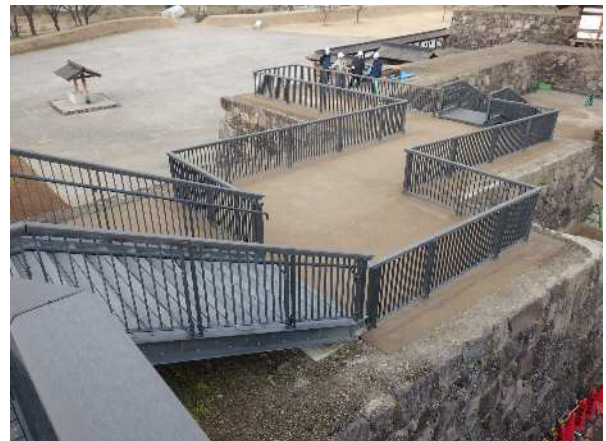
戌亥櫓台階段・柵等整備 竣工(R2.1.17)
