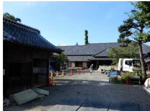
旧文武学校史跡内 工事状況
