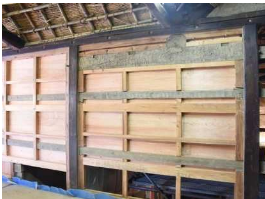
耐力壁設置による構造補強
