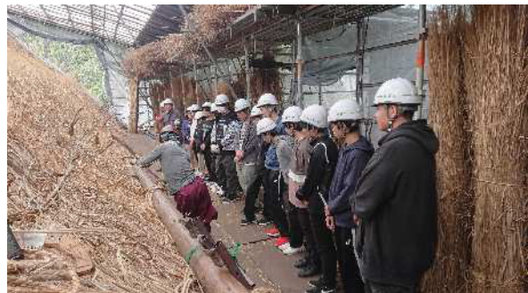
高校生の茅葺工事現場見学会の様子
