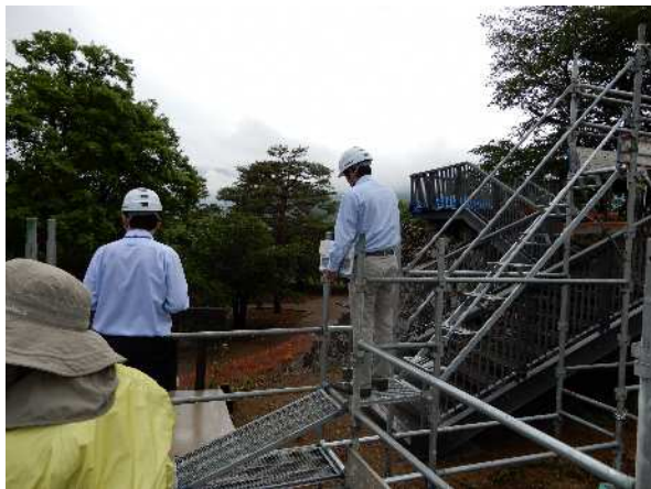
整備工事の現地指導(R1.6.11)
