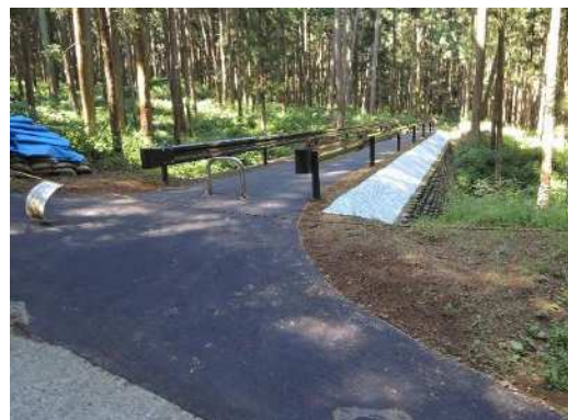
整備作業道 しゅん工の様子
