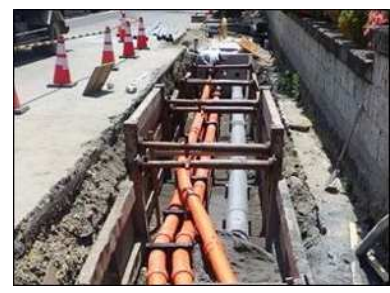
管路布設状況
