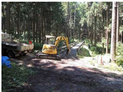
整備作業道 舗装工事の様子
