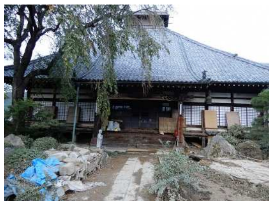
台風第19号による被害状況(松代地区)
