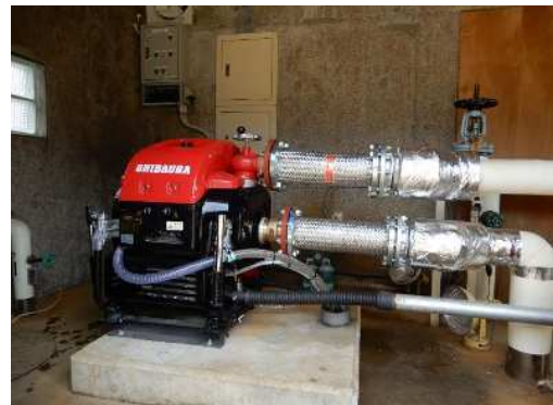
ポンプ設備の更新後
