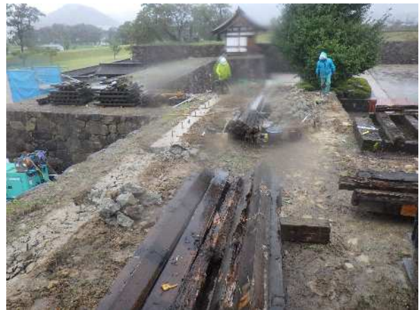
既存階段・柵等撤去状況(R1.10.25)
