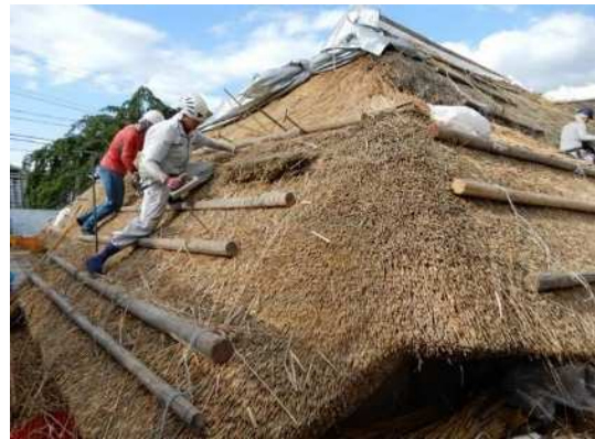
主屋茅葺屋根の葺き替え状況
