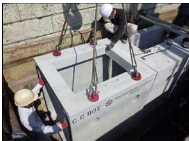
特殊部設置状況
