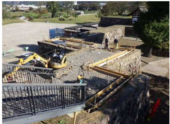
松代城跡の保存修理状況
