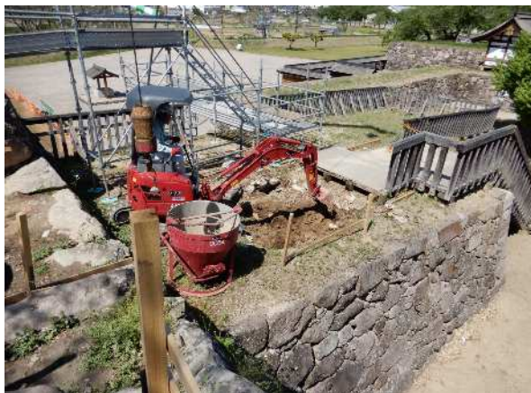
戌亥櫓台階段・柵等整備 着手(R1.5.8)
