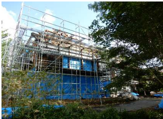
重伝建(戸隠地区)保存修理状況
