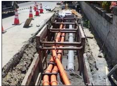
管路布設状況
