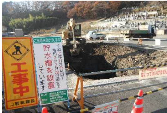
耐震性貯水槽設置工事の状況(R1.12.9)
