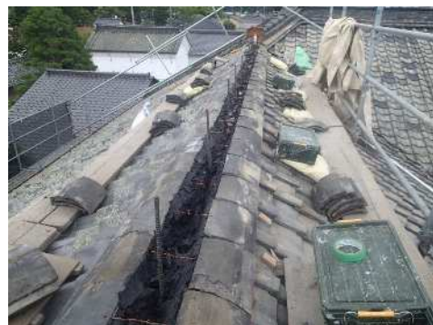
棟瓦施工状況
