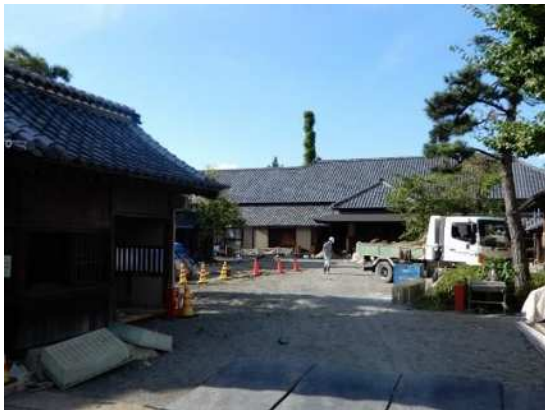
旧文武学校の保存修理状況
