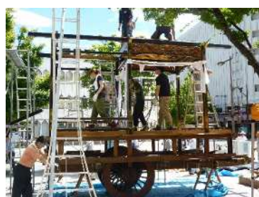
屋台組み立て状況(問御所町)
