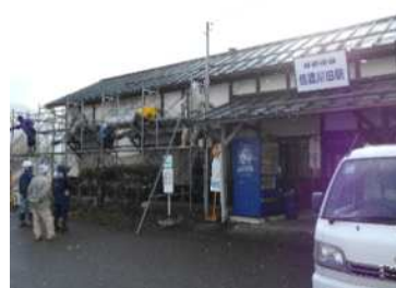
住民による駅舎壁面塗装の様子
