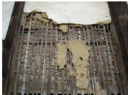
壁面破損状況・拡大(本堂/東面)
