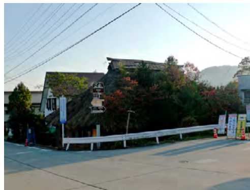
空き家となって急速に老朽化が進む民家
