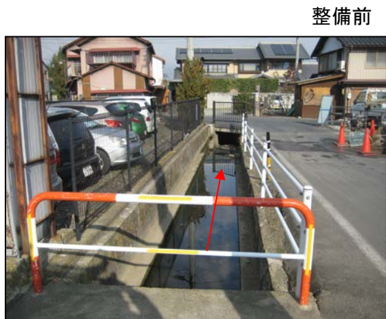
水路修景整備の状況
