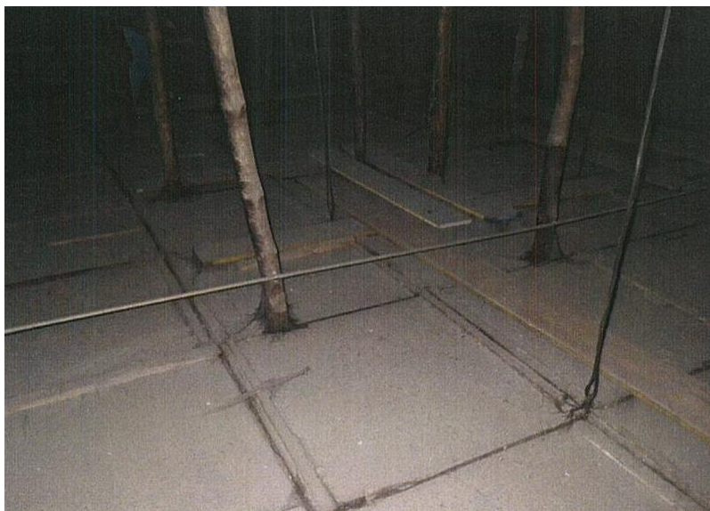
善光寺本堂 小屋裏吊天井
