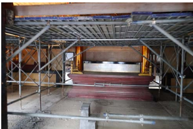
大英寺本堂内部 解体途中
