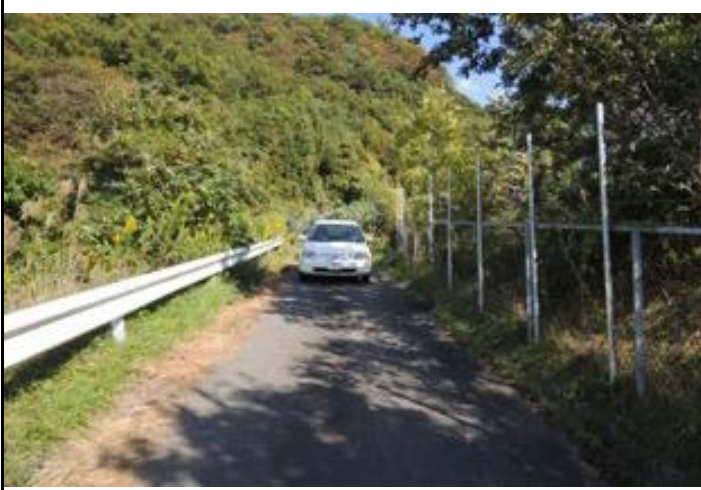
大室古墳群アクセス道路 現況
