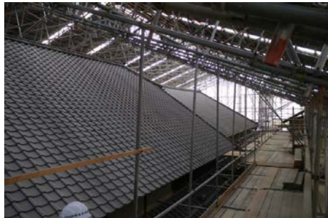
文学所 修理工事状況
