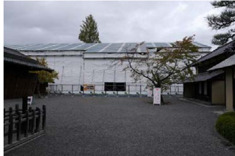
文学所 工事外観
