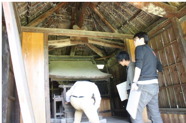
歴史的建造物調査状況
