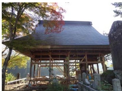
修理中(平成25年11月状況)
