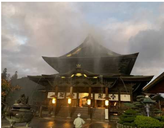
本堂 ドレンチャーの放水試験
