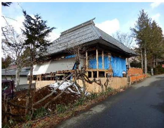
重伝建(戸隠地区)の保存修理状況
