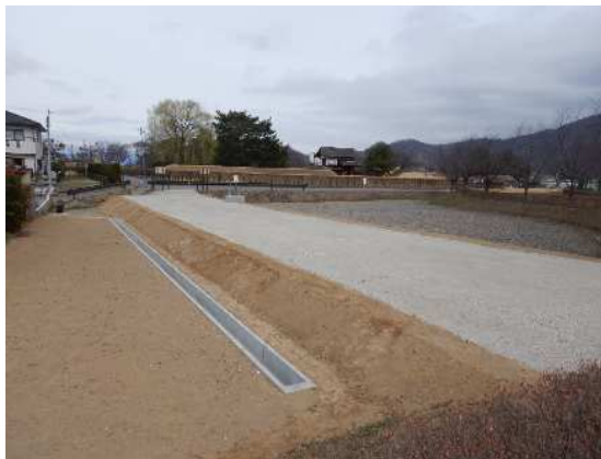
松代城跡西側園路整備工事状況の状況
