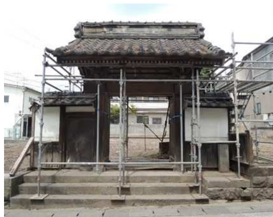
写真2 門外観(東から)撮影
