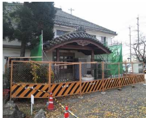
旧作新学校本館の保存修理状況
