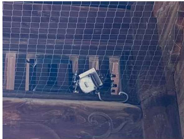
三門 炎検知器の新設
