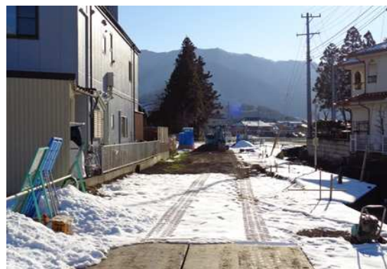
着工状況(令和4年12月現在) (Construction status as of December 2022)
