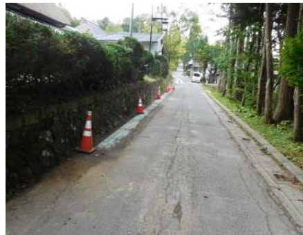
道路美装化に伴う構造物施工状況
